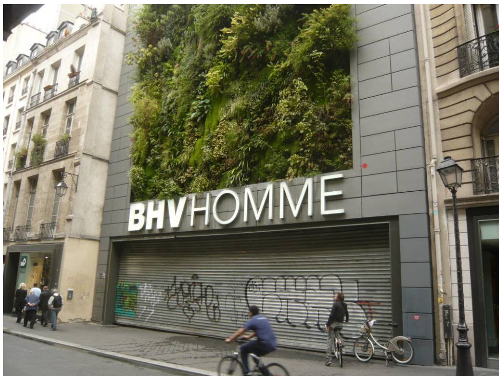
54. ábra: Zöld homlokzat
