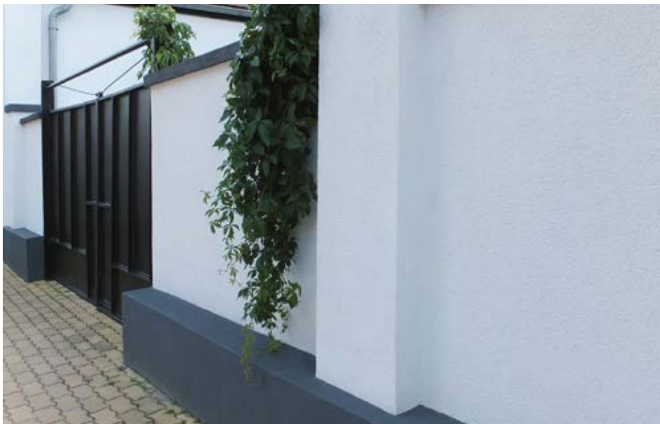
zárt kerítés kialakítása
