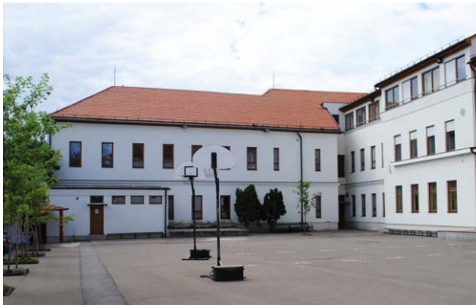
felújított oktatási intézmény, szerkezet, anyag és formaörző megújítás 126
