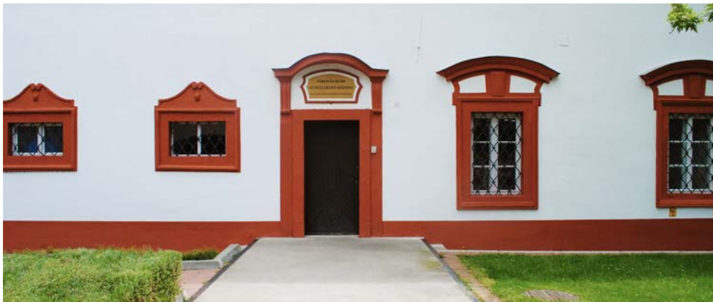
igényesen felújított történeti homlokzat, hangsúlykiemelő színezés
